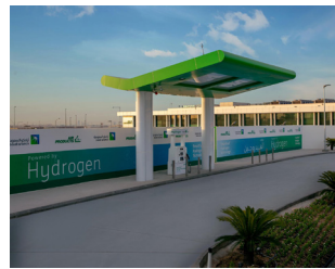
Saudi-Arabiens erste Wasserstofftankstelle
